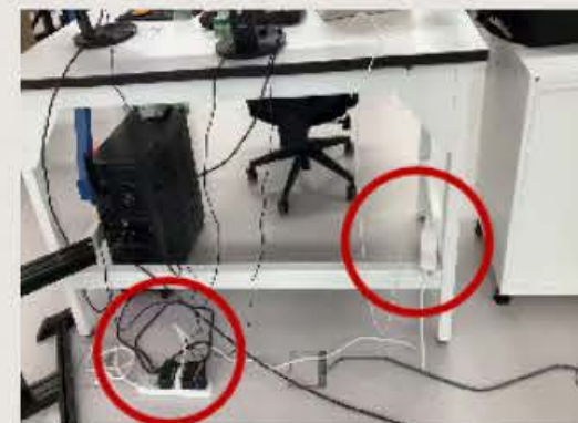
接线板串接、置于地面
