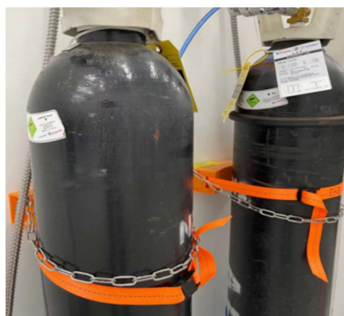
所有气瓶应该用金属链条固定，避免倾倒
